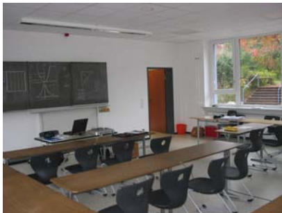
Abbildung 1: Unterrichtsraum mit Mineralfaserakustikdecke und geringem Möblierungsgrad
